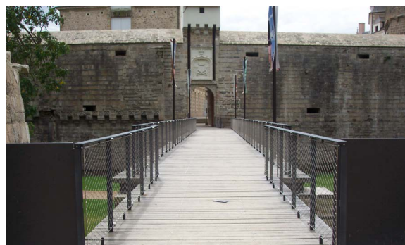
4 - Accès à la cour (rampe à droite du porche)
