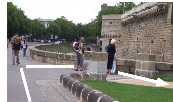
5 - Accès aux douves
