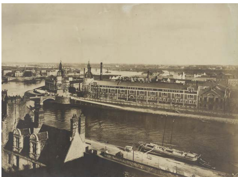
Construction des tours LU ©François Lauginie/Château des ducs de Bretagne Musée d'Histoire de Nantes
